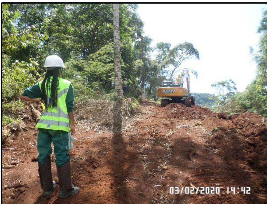
Figura 176 – Vistoria realizada durante as obras do empreendimento.
