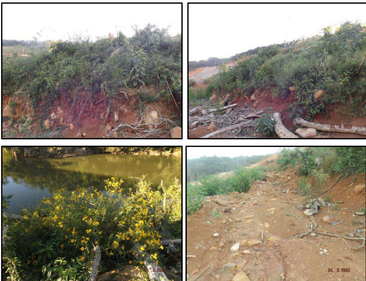
Figura 167 - Regeneração predominante de herbáceas e nas encostas dos taludes.
