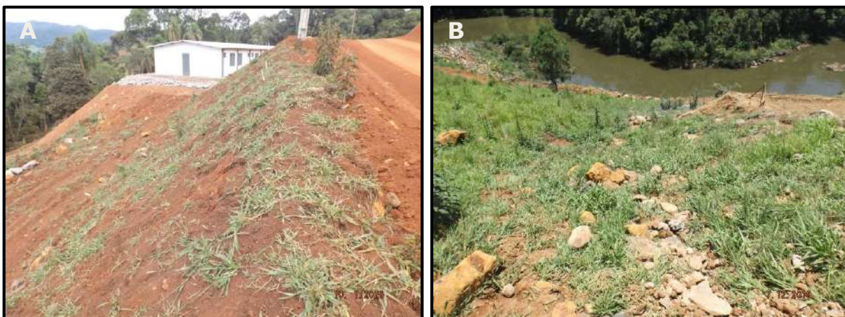
Figura 80 – Revegetação de taludes expostos com gramíneas.
