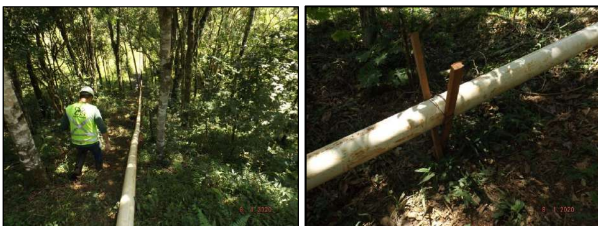
Figura 63 – Instalação de emissário para lançamento de efluentes da ETE.
