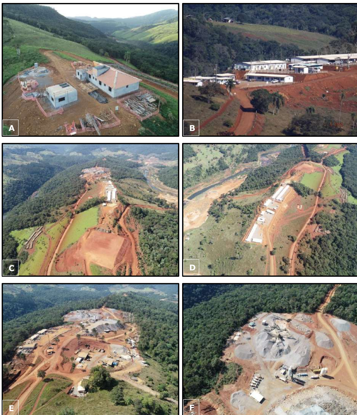
Figura 4 – Registros fotográficos do canteiro de obras da PCH Foz do Estrela.
