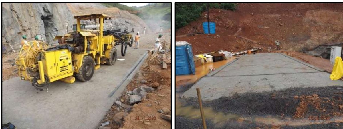
Figura 71 – Piso impermeável para manutenção de perfuratriz nas frentes de obra.
