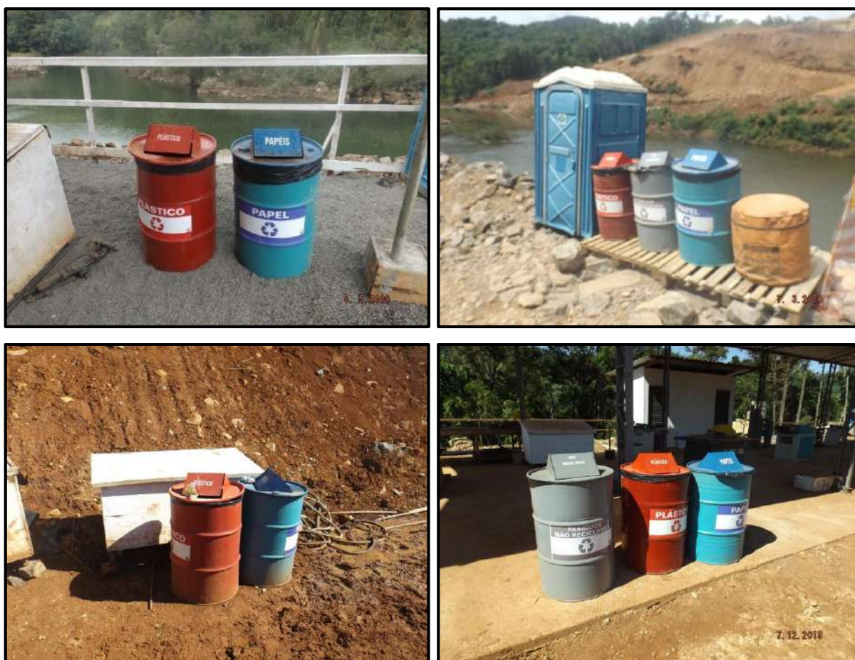
Figura 28 – Dispositivos de acondicionamento de resíduos nas frentes de obra.
