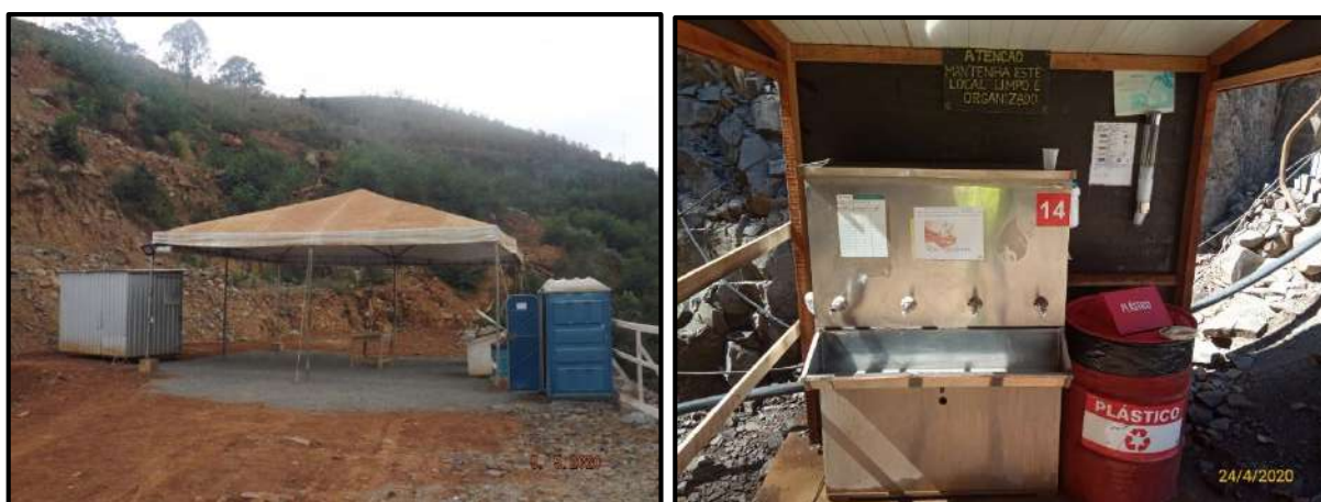
Figura 104 – Instalação de áreas de vivência e bebedouros nas frentes de obra.
