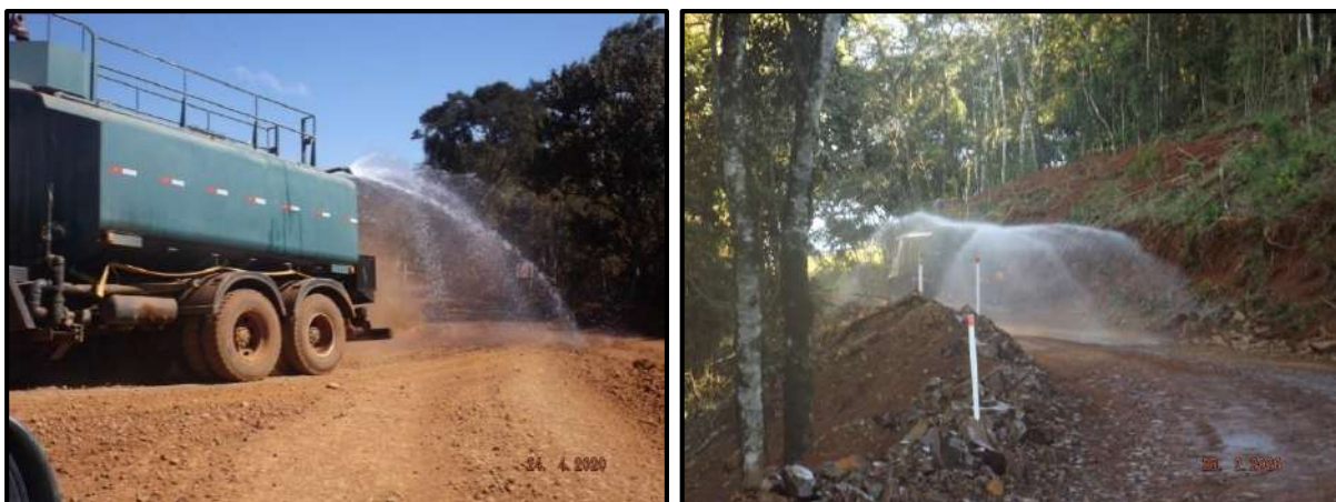
Figura 68 – Aspersão de água para umectação de vias para controle de poeira.
