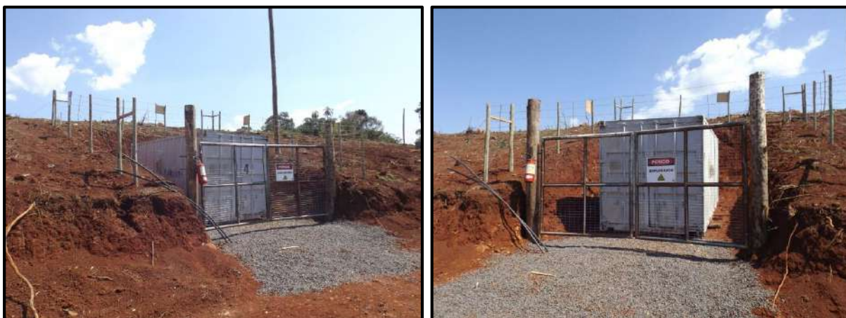
Figura 47 – Paiol de armazenamento de explosivos.
