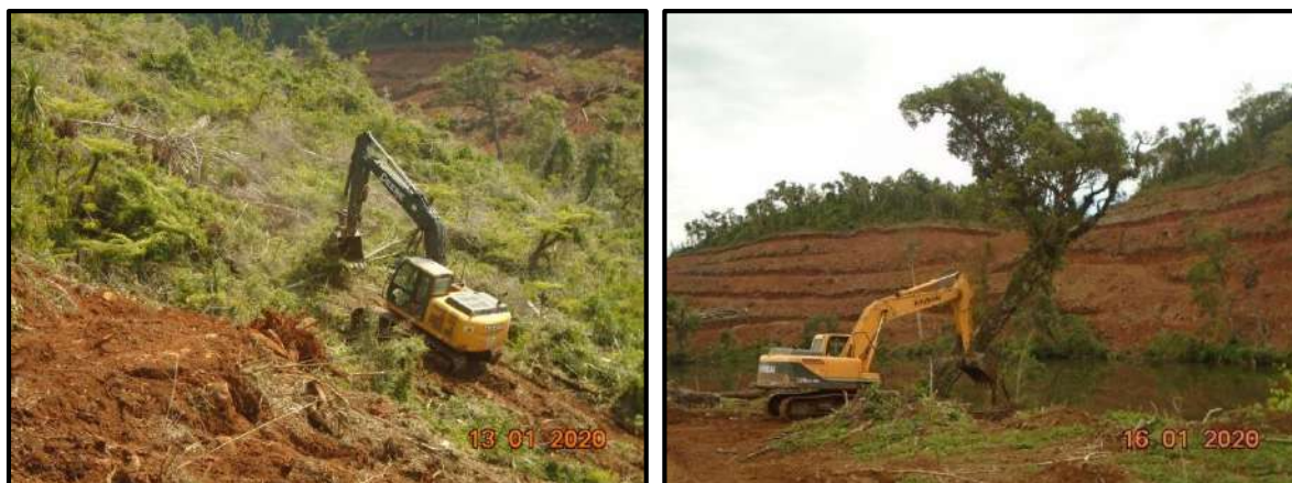
Figura 129 – Acompanhamento da supressão mecanizada.
