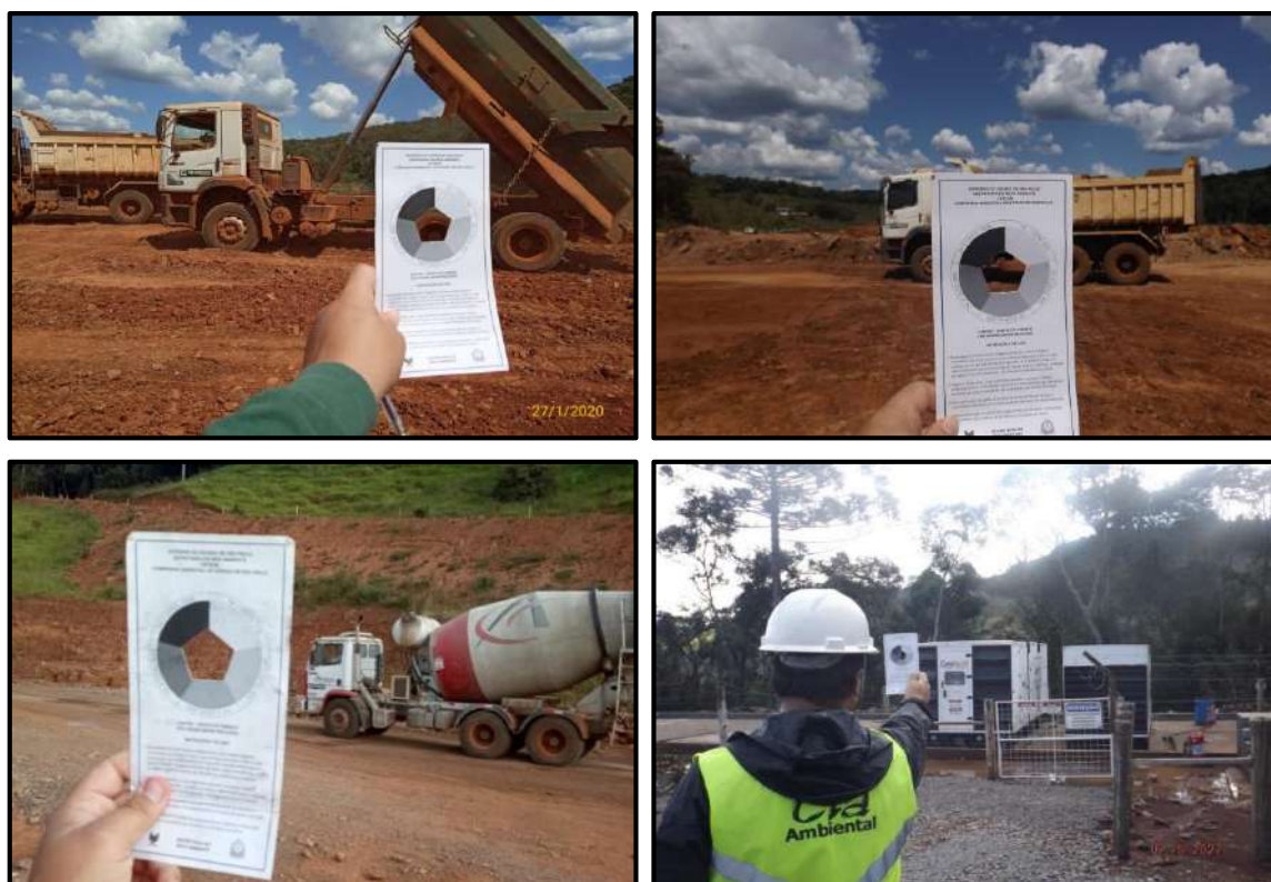
Figura 25 – Registro fotográfico do monitoramento de fumaça preta.
