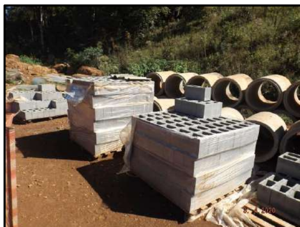
Figura 30 – Material reutilizável depositado próximo ao bota-fora.
