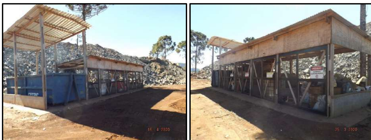
Figura 36 – Central de resíduos recicláveis e não recicláveis.
