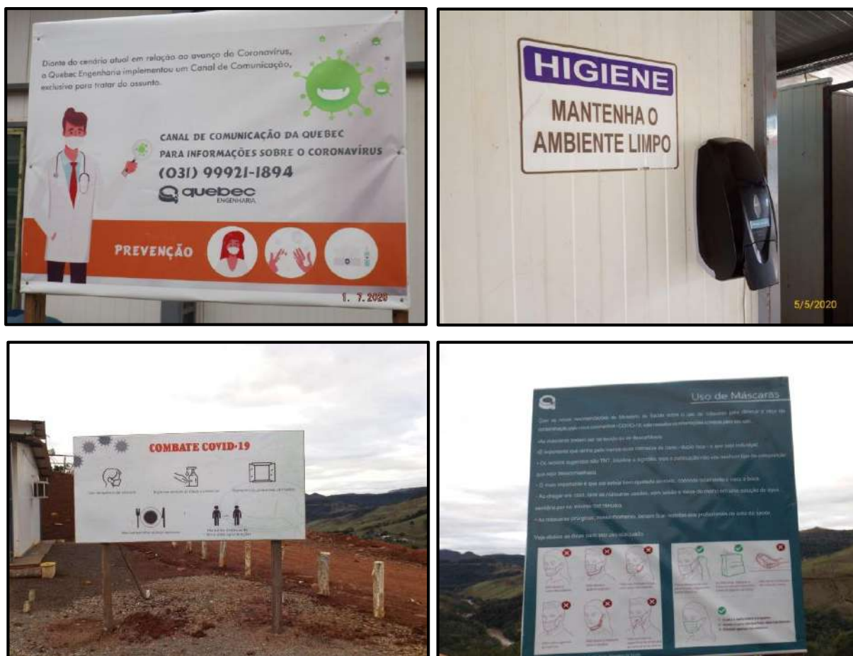
Figura 112 – Disponibilização de banners e placas orientativas no canteiro de obras.
