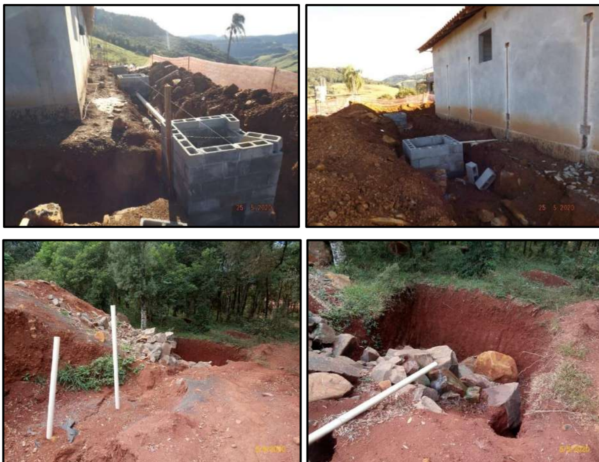
Figura 56 – Inspeções de novas estruturas de coleta, transporte e tratamento de efluentes.
