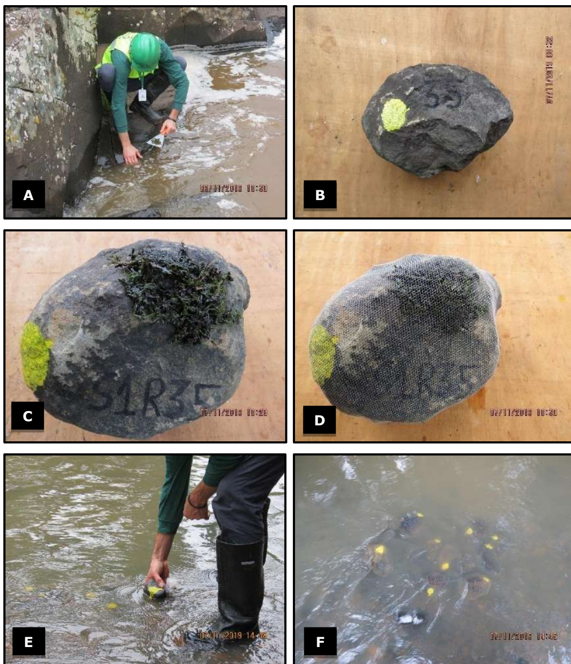
Figura 147 - Metodologia da raspagem: A – Raspagem dos lageados; B – Matacão nu; C – Deposição do material raspado; D – Fixação do tule; E – Realocação dos matacões/seixos com P. rutifolium ; F – Grupo de seixos/matacões realocados;
