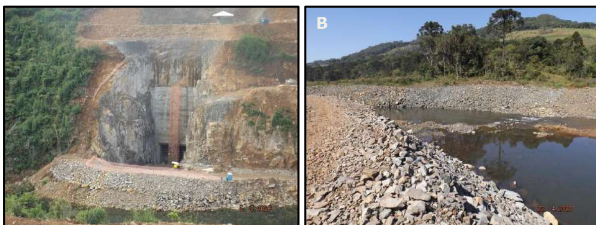
Figura 84 – Proteção de margens e enseadeiras com enrocamento.
