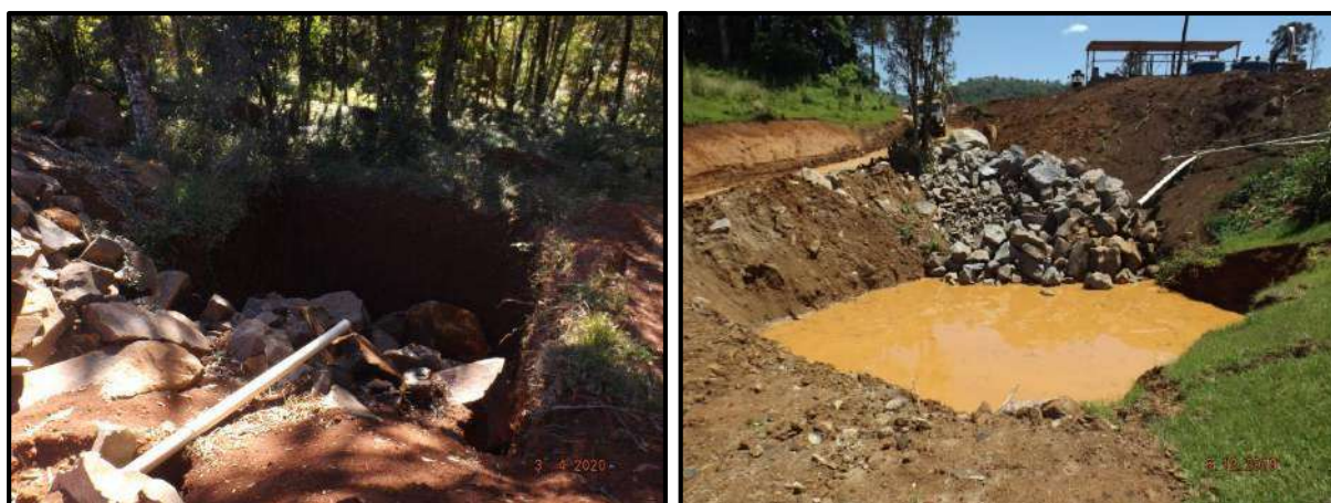
Figura 64 – Registro fotográfico de sumidouros.
