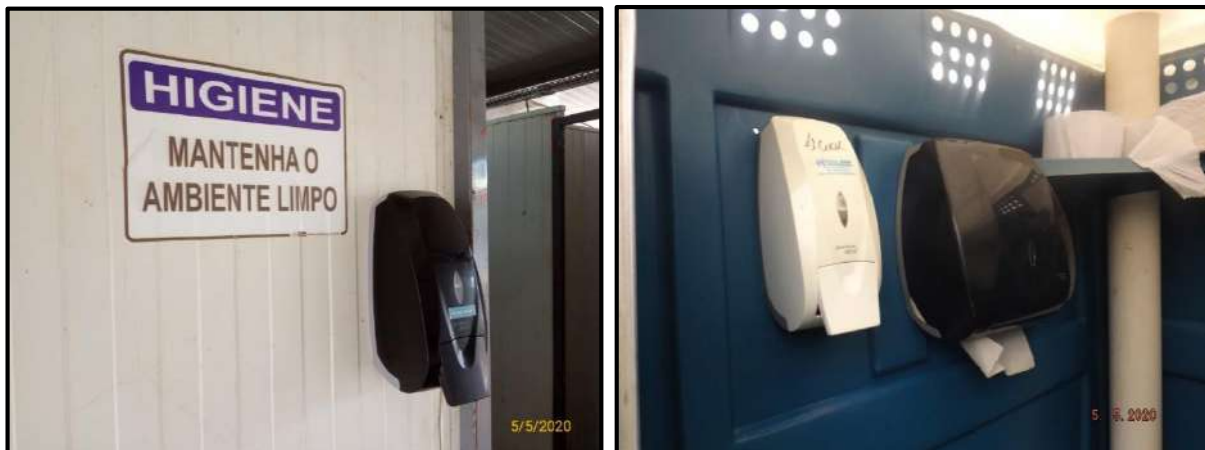
Figura 54 – Inspeções de fontes geradoras, banheiros químicos e tanques coletores de efluentes.
