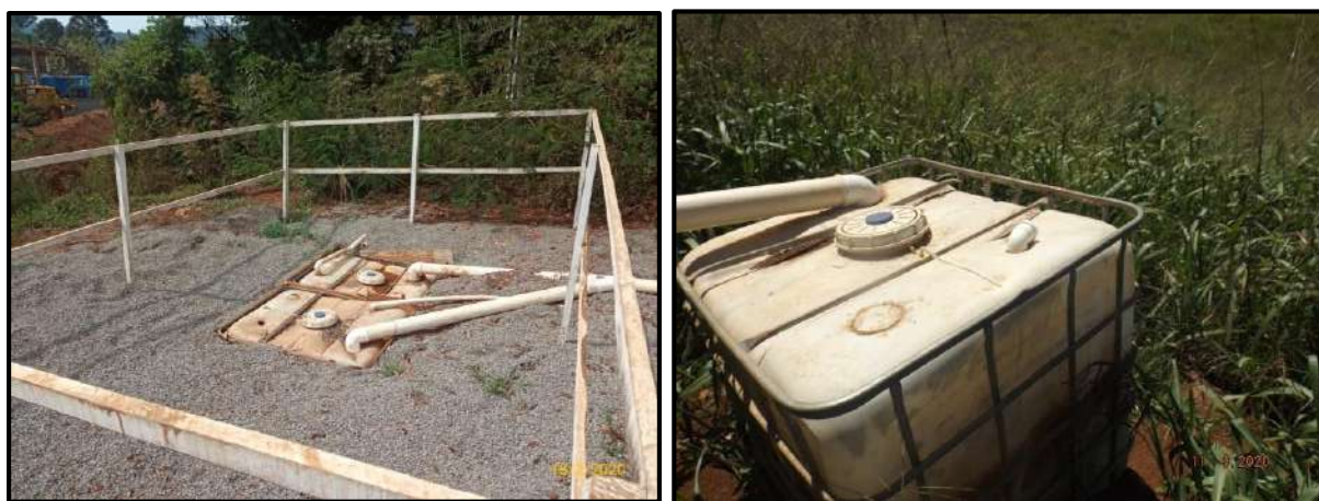
Figura 53 – Inspeções de tanques coletores de efluentes.
