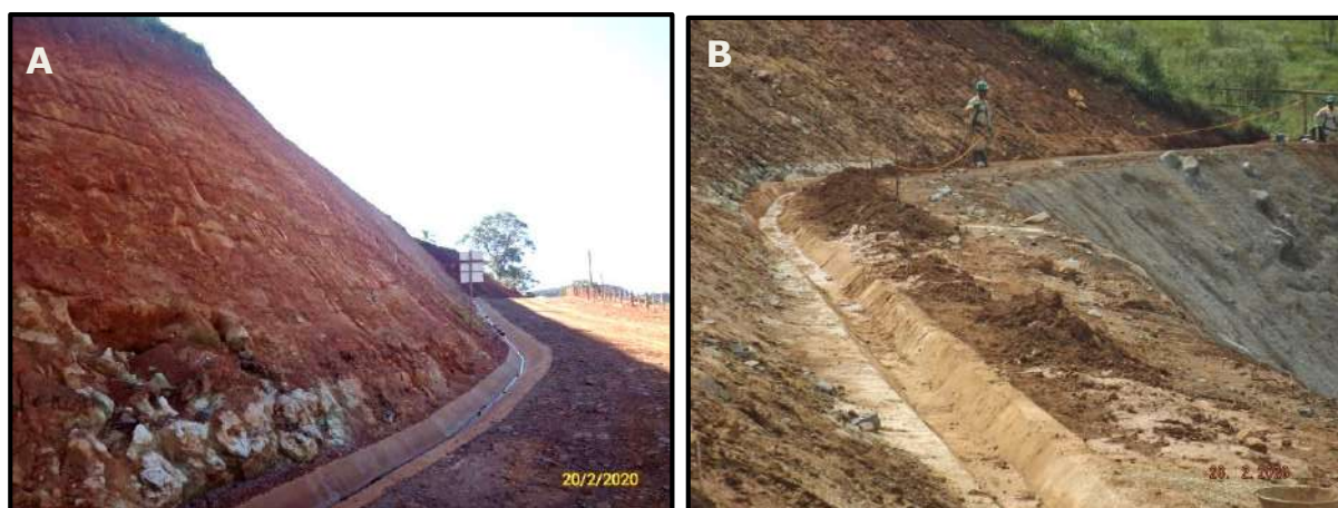
Figura 79 – Implantação e manutenção / limpeza de canaletas de drenagem.
