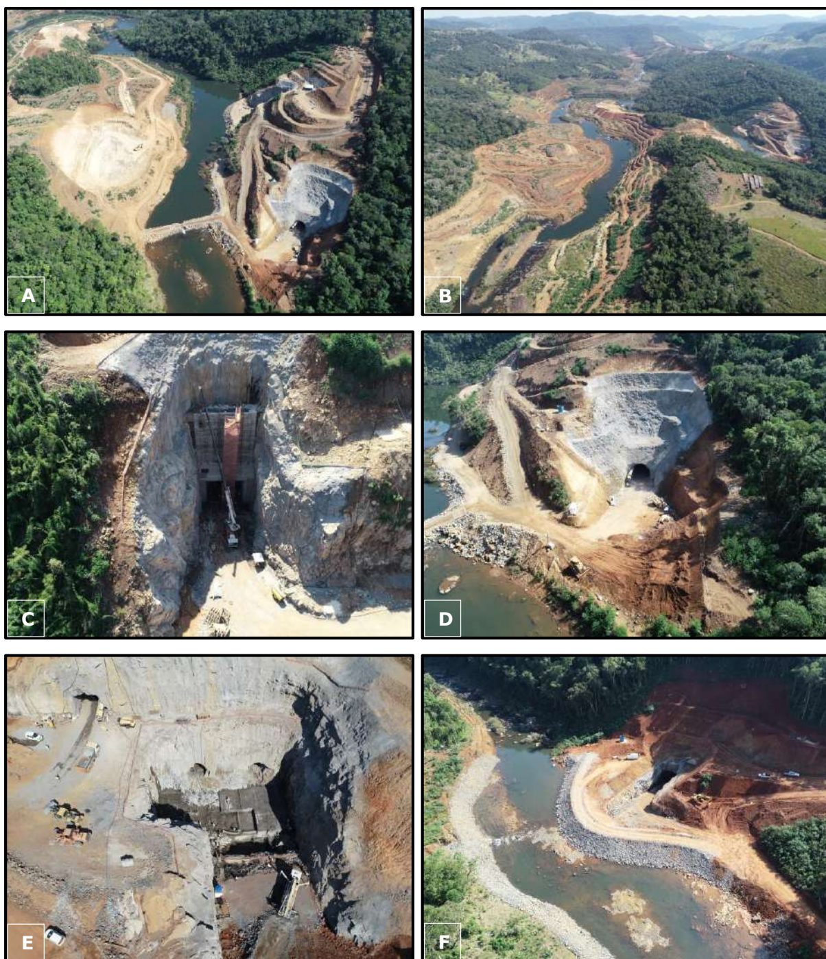
Figura 5 – Registros fotográficos das frentes de obra da PCH Foz do Estrela.
