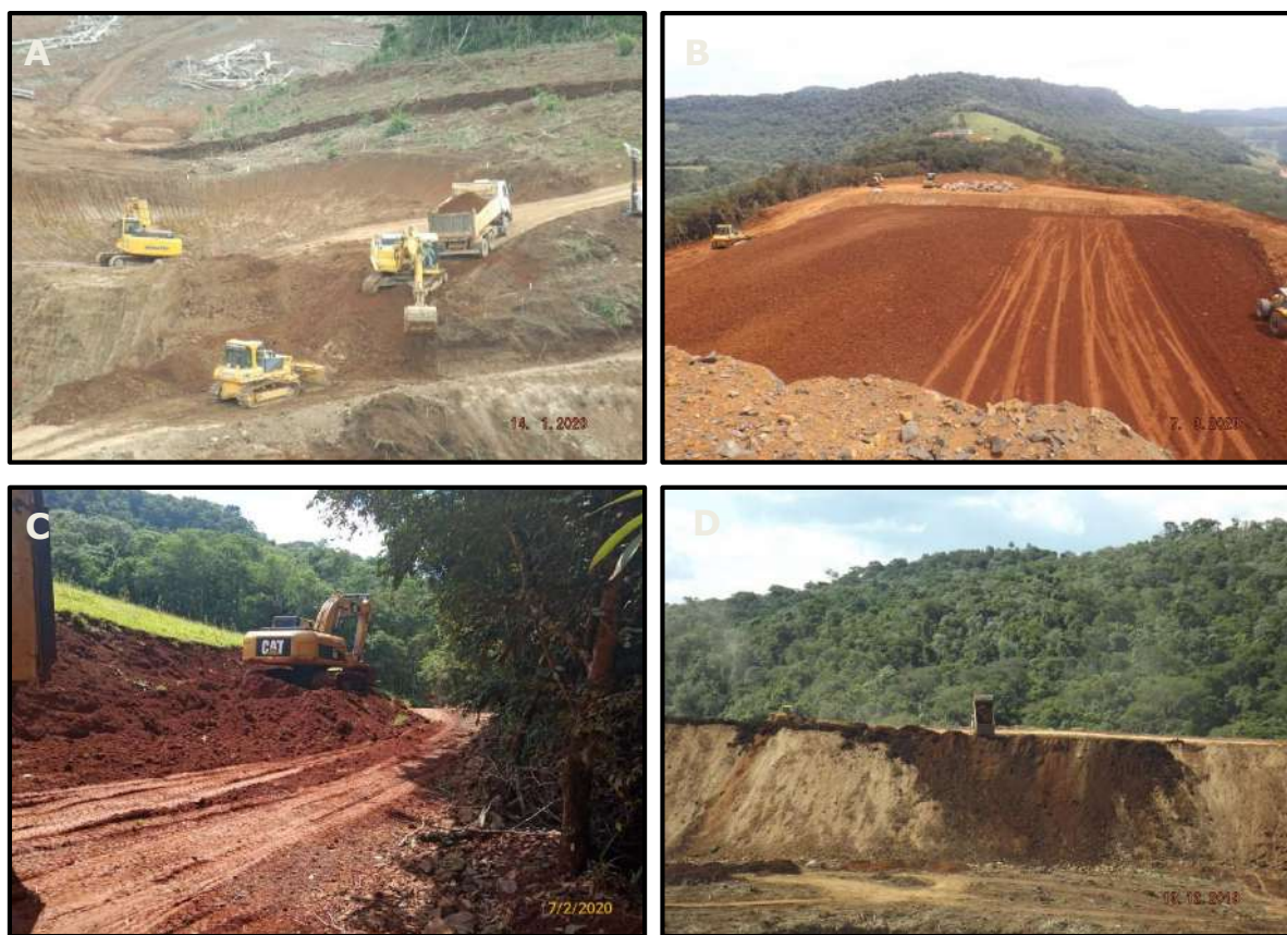
Figura 77 - Atividades de implantação que contribuem com a aceleração de processos erosivos.
