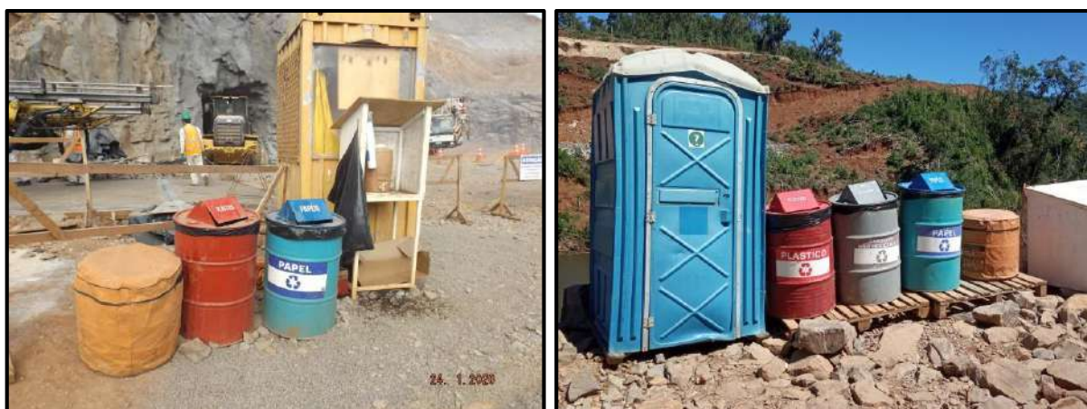
Figura 46 – Kits de proteção ambiental espalhados pelos locais de obras.
